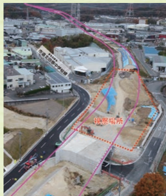
京奈和自動車道 (大和北道路)
