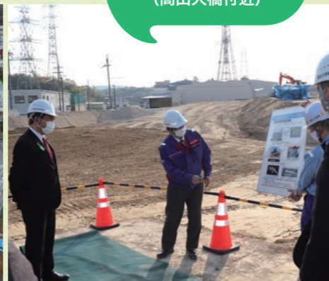
清滝生駒道路 (高山大橋付近)
